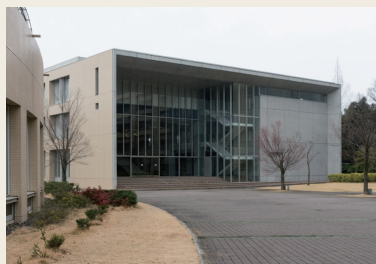
授業収録システムを導入した教室がある「総合教育研究棟フロネシス」。最先端の研究を支えるハイテクリサーチセンターも併設されている
